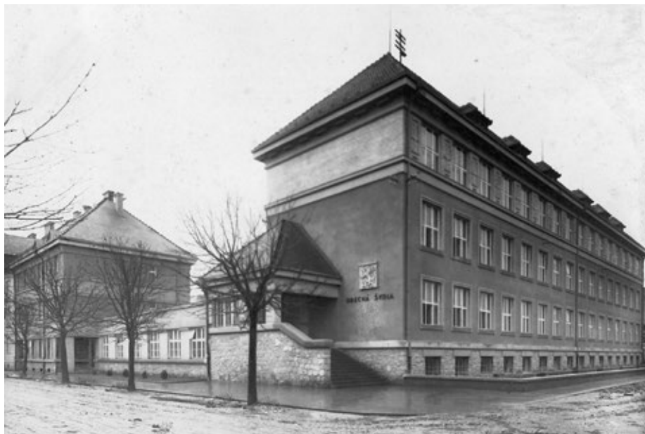
Komplex českých menšinových škol v Šumperku se vstupem do obecné školy krátce po dokončení výstavby v roce 1928. Zdroj: Vlastivědné muzeum v Šumperku.
