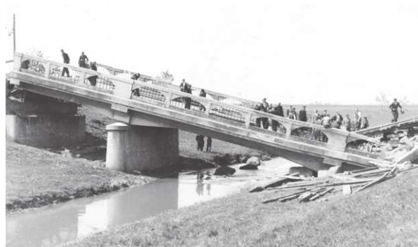
Most přes Moštěnku v Horní Moštěnici (stav z 8. května), který bránili místní povstalci (SOkA Přerov).
