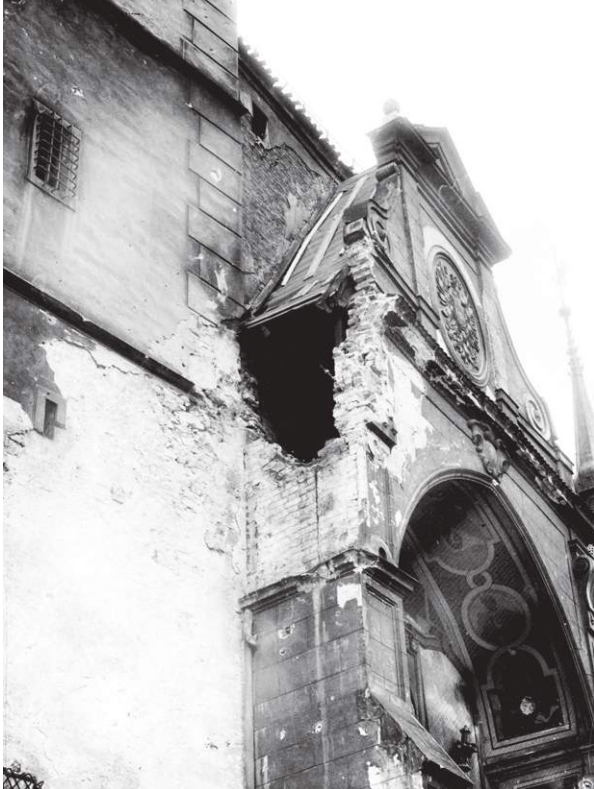
Otvor ve zdi a střeše výklenku orloje po zásahu dělostřeleckým granátem. Zdroj: Fotoarchiv Vlastivědného muzea v Olomouci.
