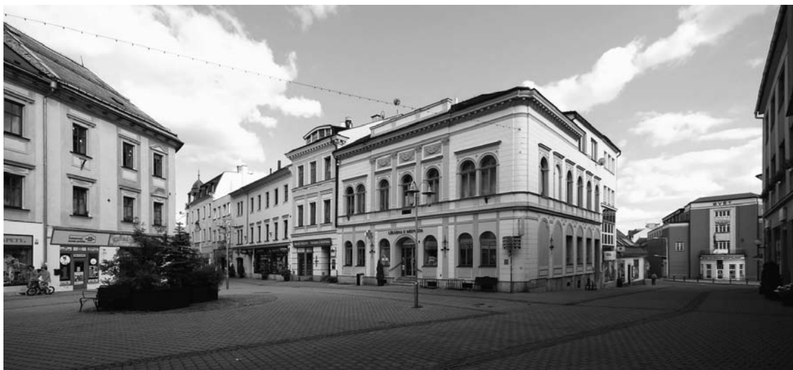
Nárožní budovu lékárny U Medvěda si nechal postavit v roce 1885 podle projektu šumperského rodáka, vídeňského architekta K. Seidla, lékárník E. Hackl. Průčelí jejích historizujících fasád čerpají z podnětů klasicizující renesance. Foto: J. Pavlíček
