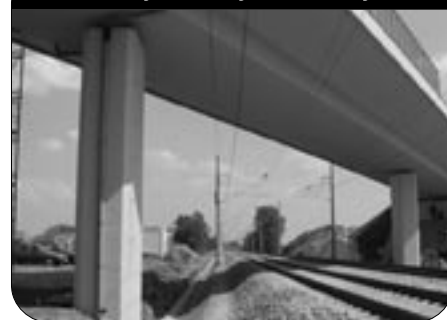
Mosty a inženýrské stavby
