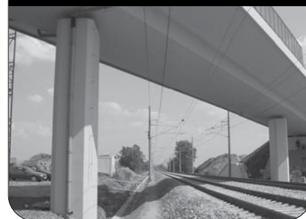
Mosty a inženýrské stavby
