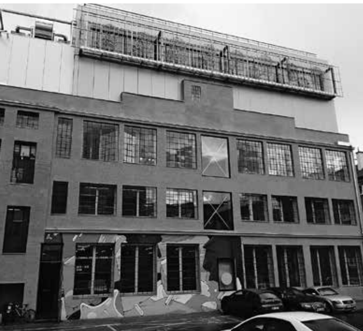
Budova Telegraphu. Foto: Renáta Chalupová.
