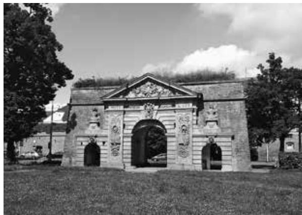
Nejvýraznějším pozůstatkem opevnění je Terežská brána. Foto: Tomáš Chalupa.
