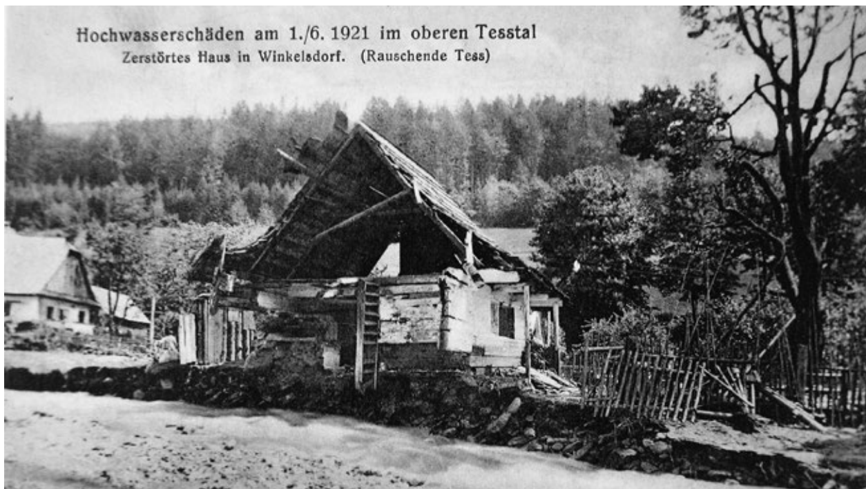
Vážně poškozené stavení v Koutech nad Desnou. Zdroj: Vlastivědné muzeum v Šumperku.
