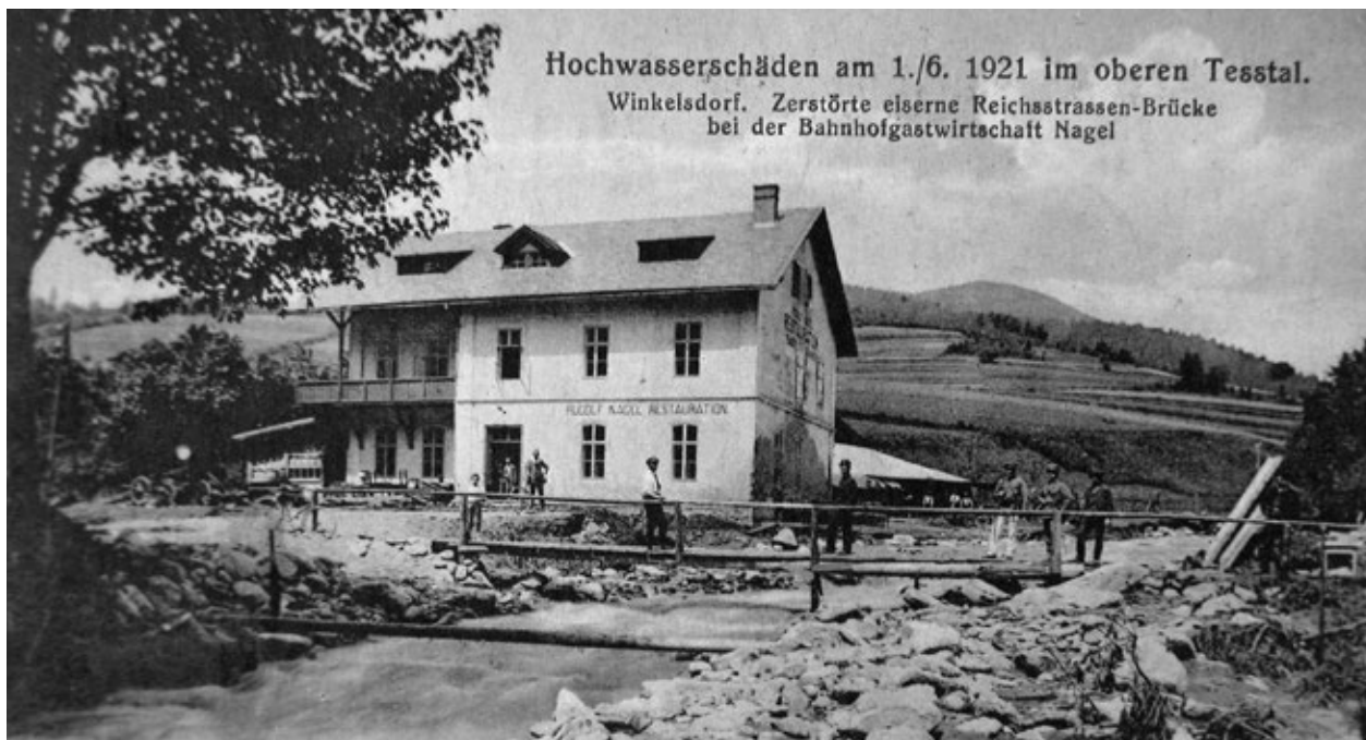
Rozbouřené vody s sebou strhly také železný most u Nagelova hostince v Koutech nad Desnou, dočasně jej nahradila provizorní lávka. Zdroj: Vlastivědné muzeum v Šumperku.
