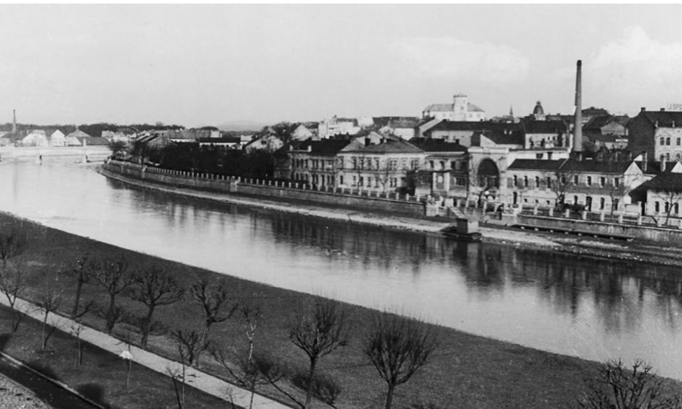
Pohled na Stojanovo nábřeží s elektrárnou, 30. léta 20. století. Zdroj: SOkA Písek.
