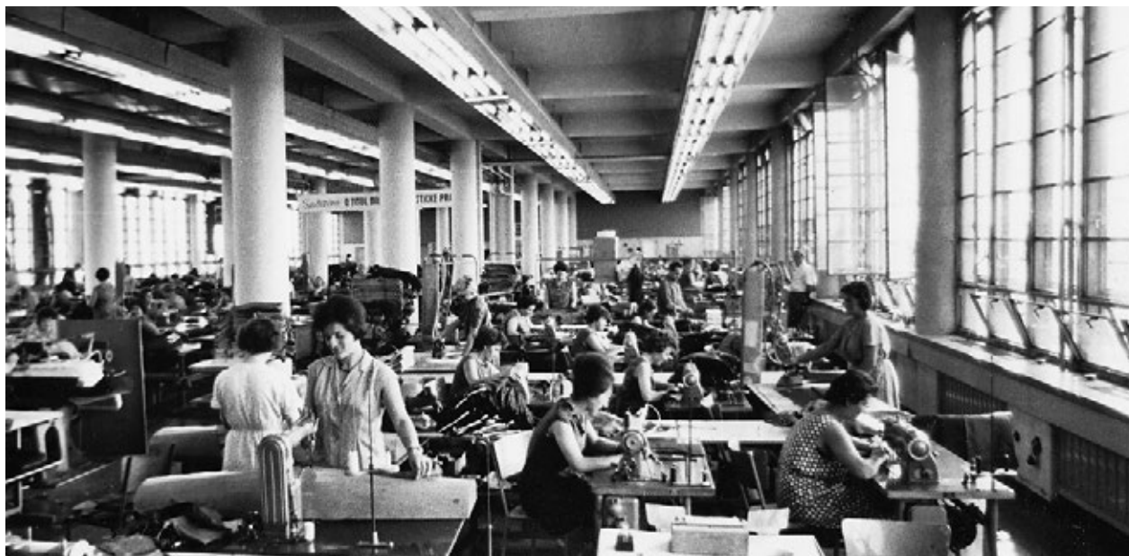
Výrobní hala OP Prostějov. Zdroj: archiv MGP.
