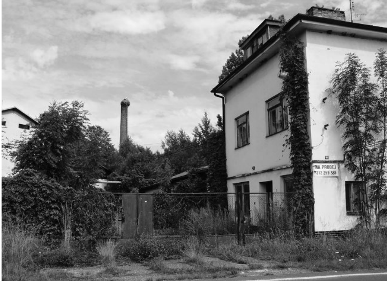
Opuštěný závod marně čeká na kupce. Foto: autor článku.
