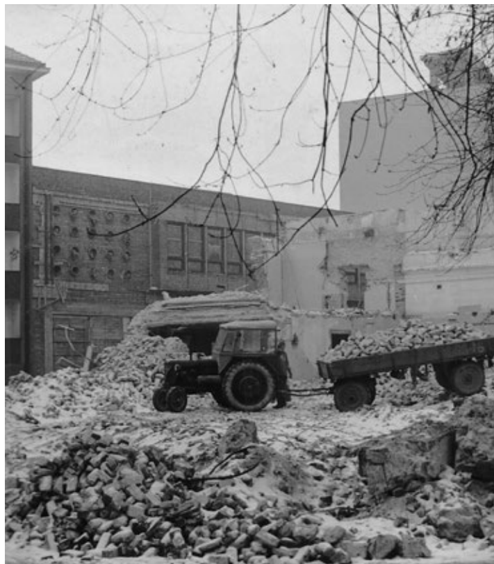
Bourání staré elektrárny a výstavba restaurace Bečva, 1964. Zdroj: SOkA Přerov.
