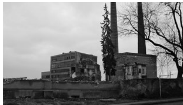
Brodecký cukrovar v průběhu demoličních prací, 6. 1. 2018. Foto: Petr Jiráček.
