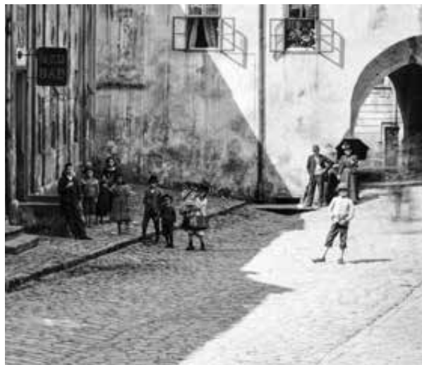
Vodárná ulice před zavedením kanalizace. Spádovaná dlažba z bělkovické droby. Zdroj: digiarchiv SOKA Olomouc.
