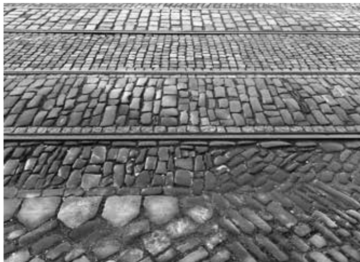
Různé typy historické dlažby v Sokolské ulici. Zpředu dozadu: vrstevnatý kámen kladený úhlopříčně se zbytkem bordury z tzv. biskupských čepic, mezi kolejemi jsou kladeny do řádků: bělkovická droba, malá žulová kostka, velká žulová kostka. Foto: autor.
