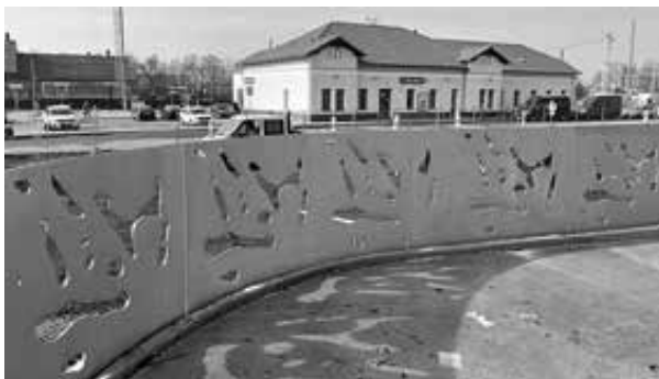
Šternberské nádraží po rekonstrukci (pohled z přístupového chodníku). Zdroj: Wikimedia Commons.
