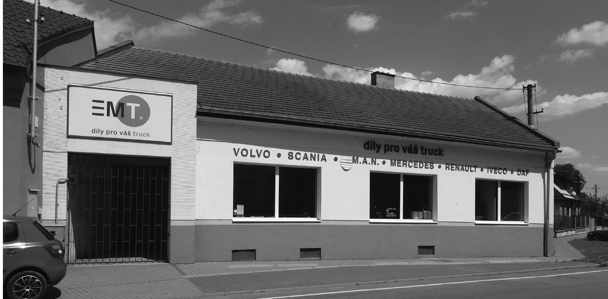
Budova někdejšího hostince Bedihošť č. p. 41. Foto: Jan Jirák.
